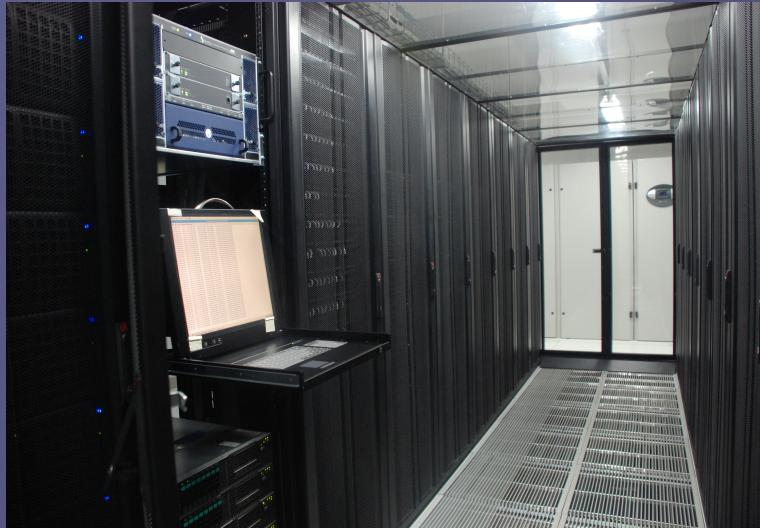
性能描述：85 个计算节点，通过 Infiniband 高速网络连接；每个节点安装了 2 个 4 核的 Xeon E5520 中央处理器，24GB 内存，CPU 理论峰值为 1.5 万亿次；每个节点安装了 2 块 Nvidia C1060 图形加速卡，理论单精度浮点计算峰值约为 160 万亿次。
